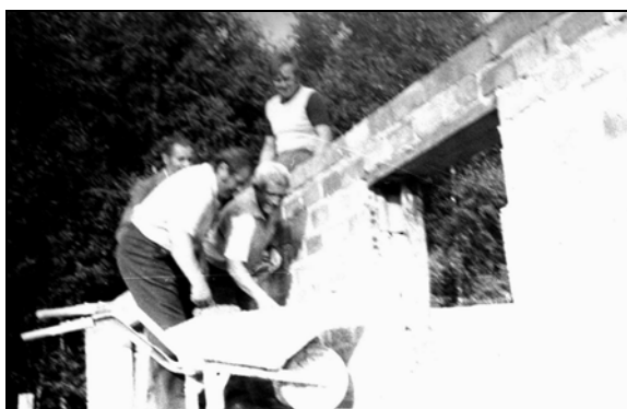
Wylewanie progów i wieńca
