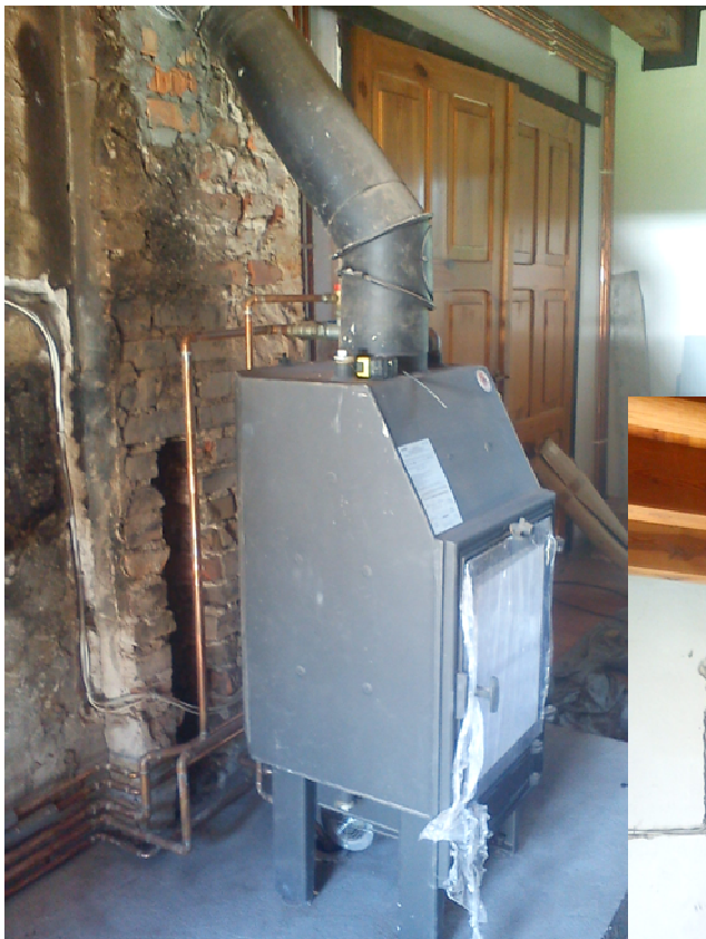
Przebudowa kominia z nowym metalowym wkładem
