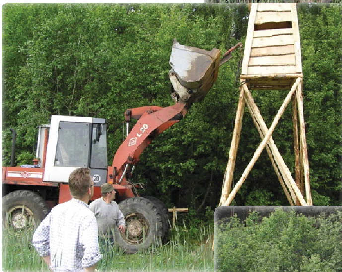
Budowa ambony na Obwodzie 124 Wilcze Łaski
