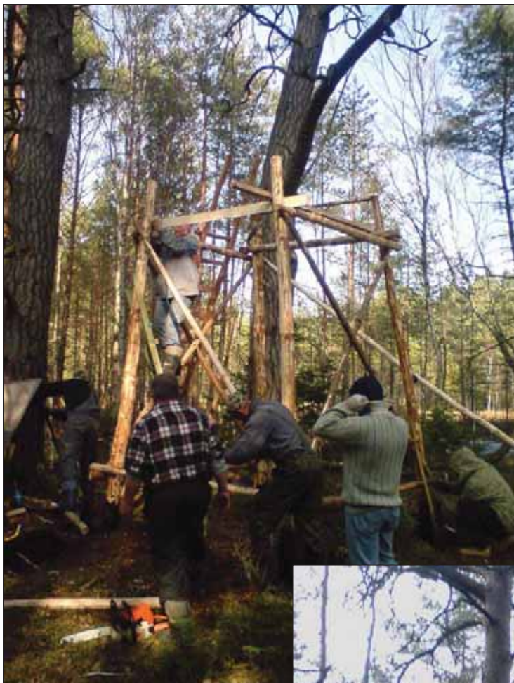
Efekt budowy widoczny na zdjęciach.
